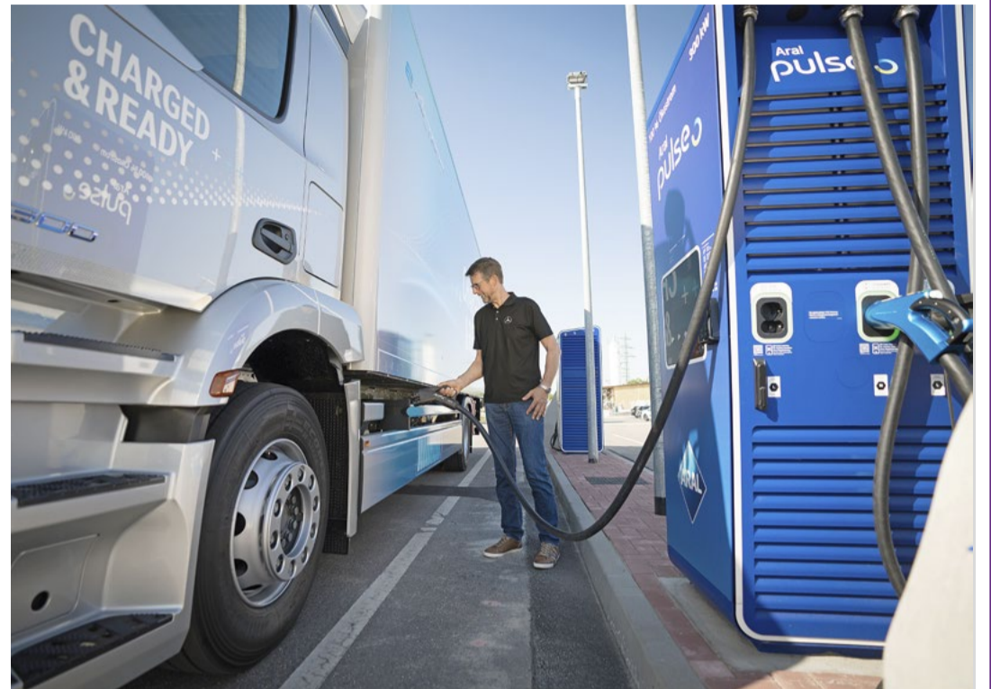
Lkw-Ladesäulen sind aktuell noch Mangelware. Für den Markthochlauf von E-Lkw sind sie aber Grundvoraussetzung.
